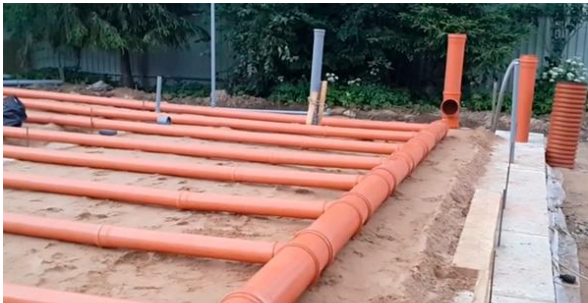
Рисунок 3.9 – Грунтовой трубный теплообменник
