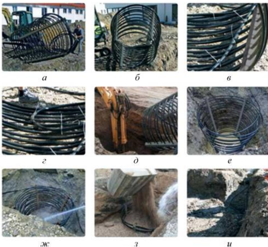
Рисунок 1.5 – Монтаж энергокорзины: а – отделение труб подводки; б – установка труб подводки в определенном положении; в – фиксация обратной трубы; г – фиксация падающей трубы; д – рытье котлована для установки; е – размещение энергокорзины в котловане; ж – заливка котлована; з – засыпка энергокорзины; и – установленная энергокорзина после уплотнения грунта
