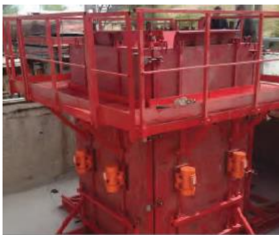
Рисунок 14 – Наружная опалубка с наружными вибраторами
