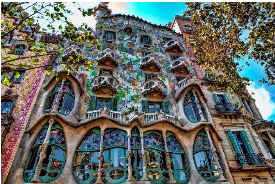
Рис. Г.1. Дом Бальо, Испания
