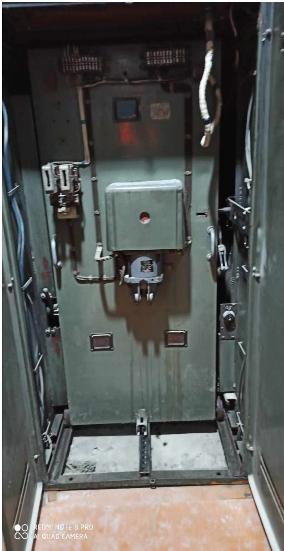
Рисунок 2 – Вид спереди выкатной тележки в камере КРУ-6 кВ
