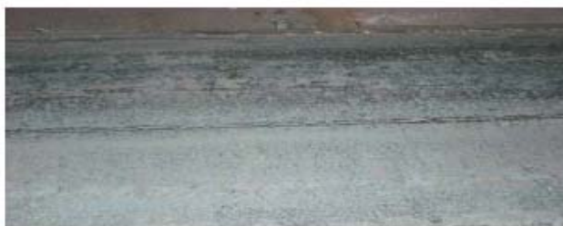
Рисунок 5 – продольные трещины
