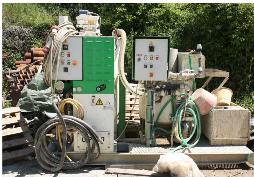
Рисунок 11 – Мобильная буровая установка для цементации грунта.
