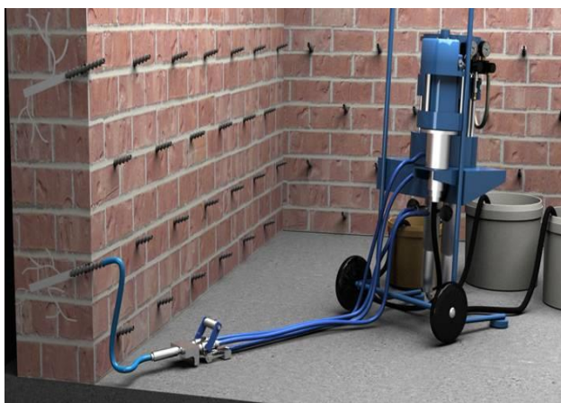
Рисунок 13 – Инъектирования кирпичной кладки
