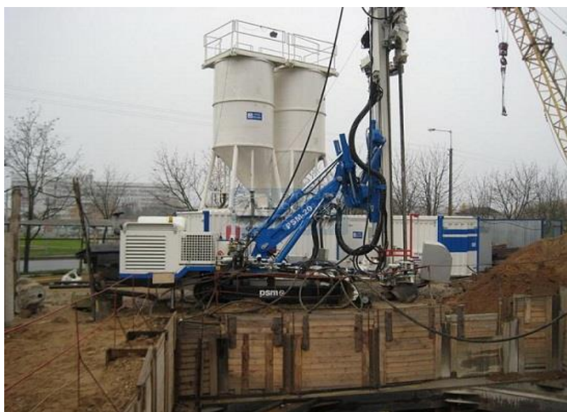
Рисунок 10 – Буровая установка для цементации грунта.
