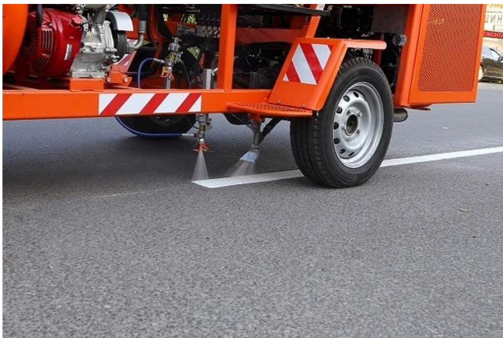
Рисунок 28 – Нанесение разметки после зимнего сезона
