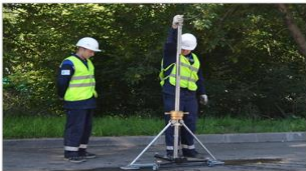
Рисунок 11 – Проведение испытаний и отбор образцов (проб) с участка дорожной одежды
