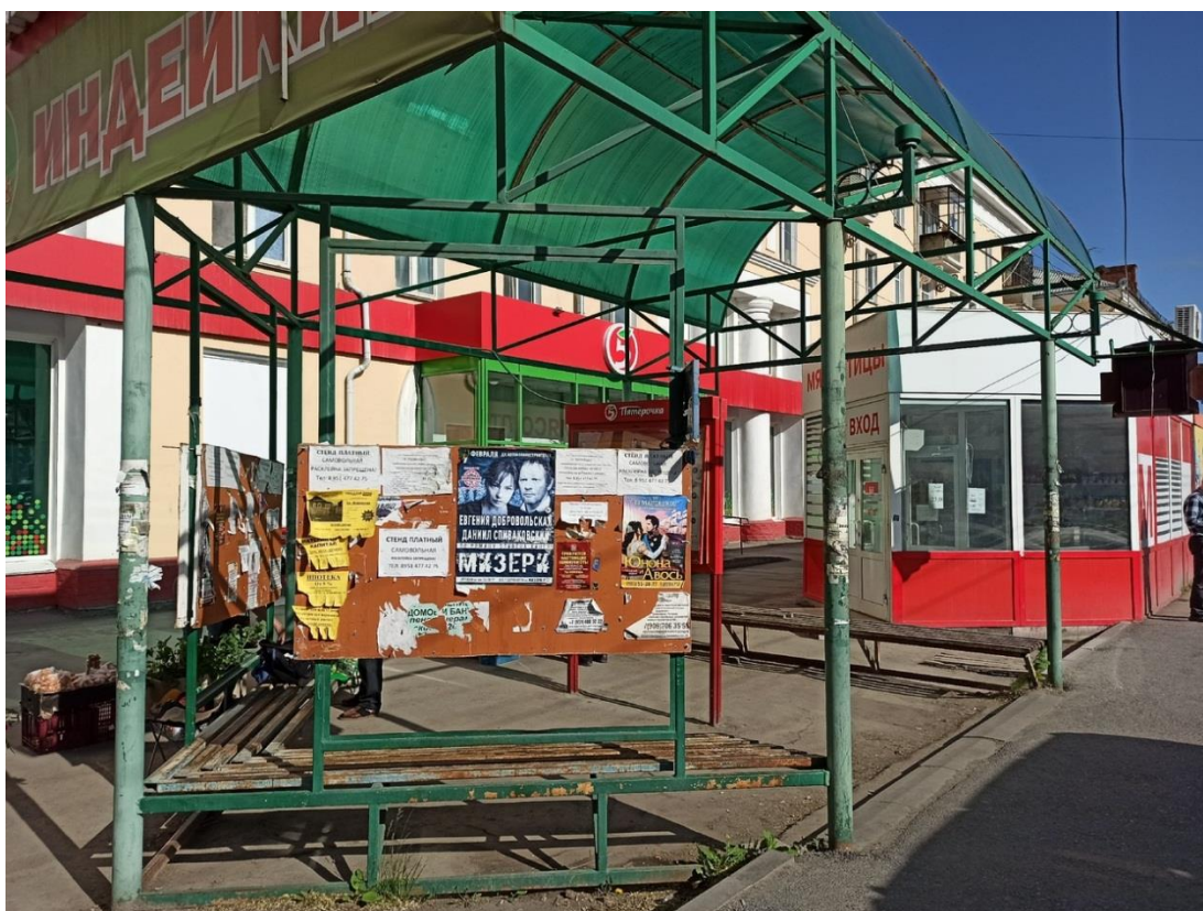
Рисунок 4 – Оборудованный остановочный пункт
