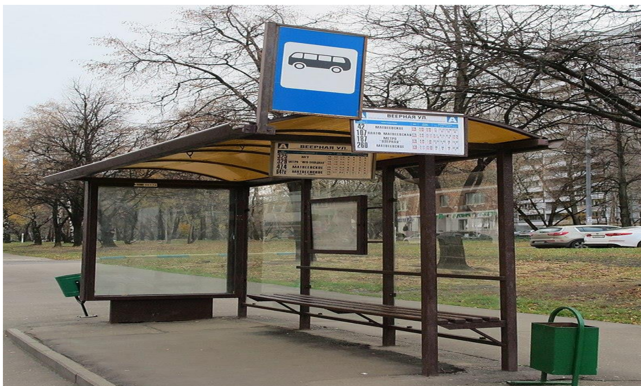
Рисунок 16 - Оборудованный остановочный пункт
