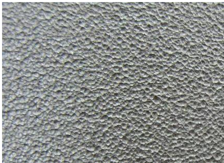
Рисунок 1.1 – Поверхность металла после пескоструйной обработки
