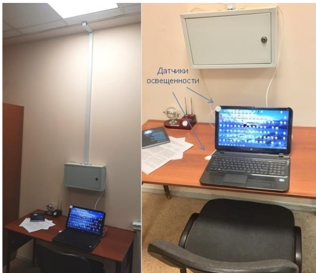
Рисунок 11 – Внешний вид, собранной СУО
