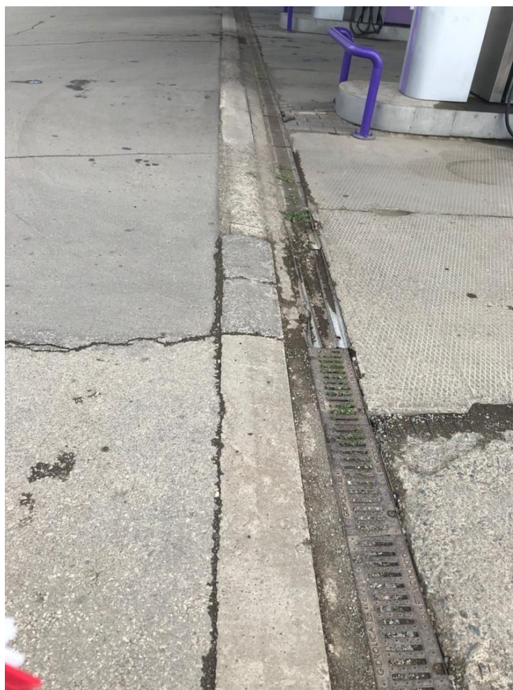
Рисунок 11 – Засыпанный ливневый сток канализации
