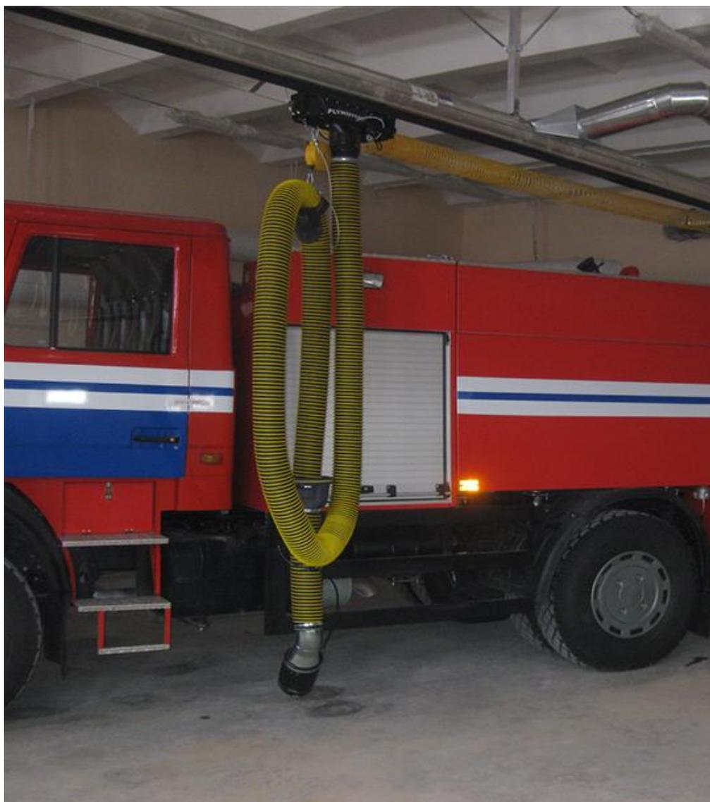
Рисунок 1.2 – Отводящее выхлопные газы устройство
