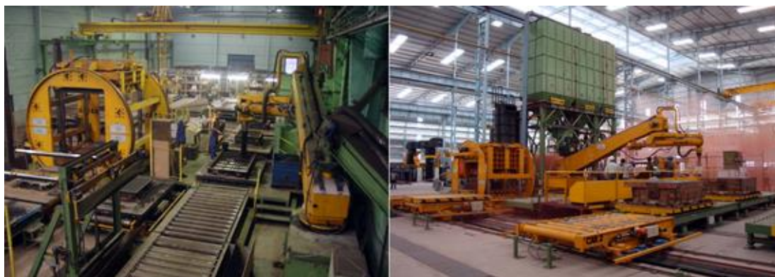
Рисунок 8 – Внешний вид цеха с установленной системой FAST-LOOP
