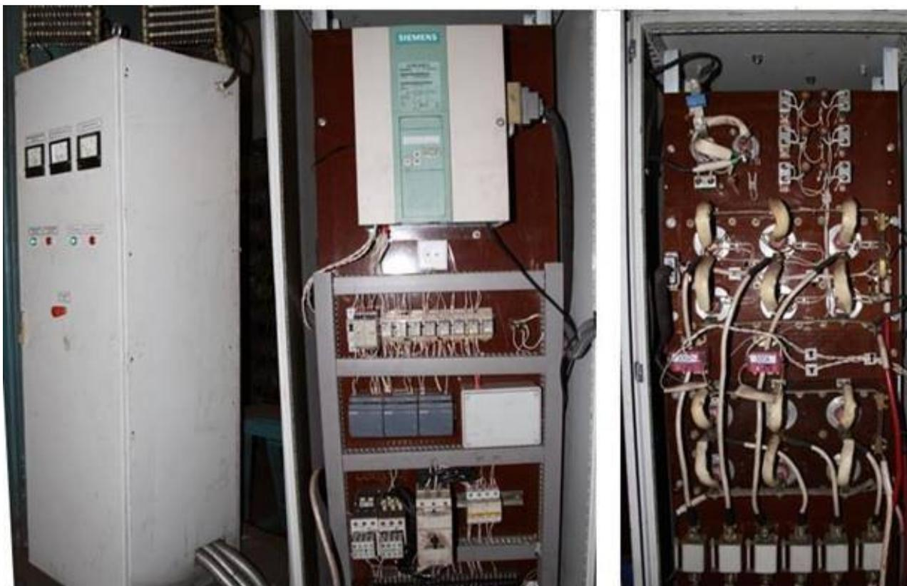
Рисунок 2.9. Шкаф управления преобразователем частоты
