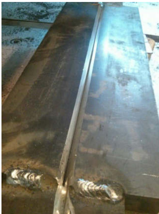
Рисунок 3.1 – Контрольное сварочное соединение
