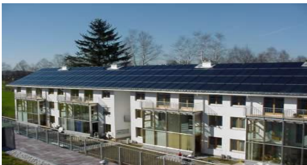
Рисунок 4.4- Плоские коллекторы в здании [9]
