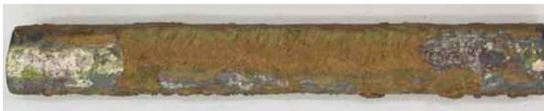
Рисунок 4.1 – Фрагмент трубы котла ОКГ 160
