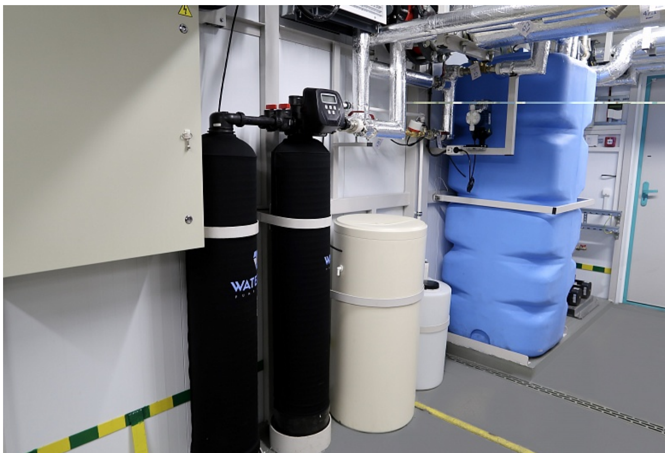
Рисунок 4.7 – Автоматический фильтр-умягчитель непрерывного действия WS1TT S1465TMI-300 фирмы «Water Technics»
