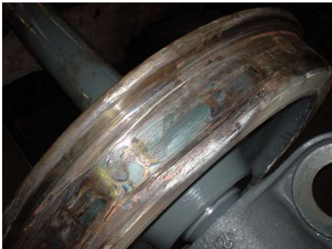
Рисунок 10 Износ двухребордных крановых колес
