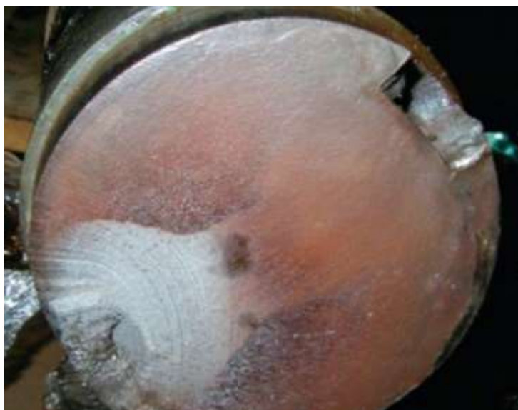
Рисунок 12 Усталостное разрушение вала приводного колеса мостового крана
