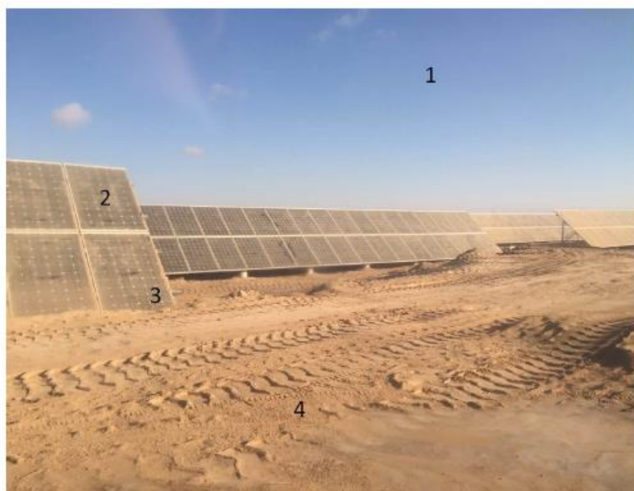
Рис.5.10 Факторы, влияющие на пылевое загрязнение фотоэлектрических модулей в пустынных районах: 1-климатическое воздействие, концентрация пыли в окружающей среде, 2-Характеристики остекления, адгезионные эффекты, неравномерное загрязнение, 3-условия установки, 4-окружающая среда, характеристики пылевых частиц
