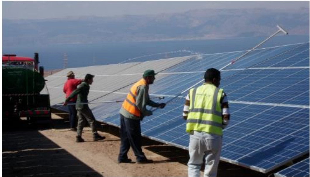
Рис. 5.11 Ручная очистка фотоэлектрических панелей
