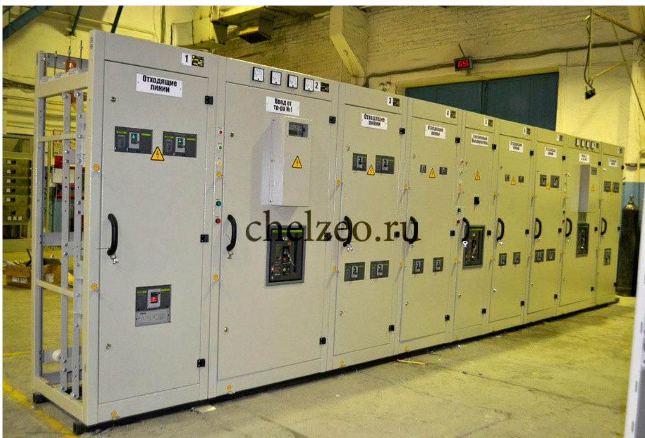
Рисунок 2.15 – Размещение выбранных АВ в стандартных ячейках ЩО-70
