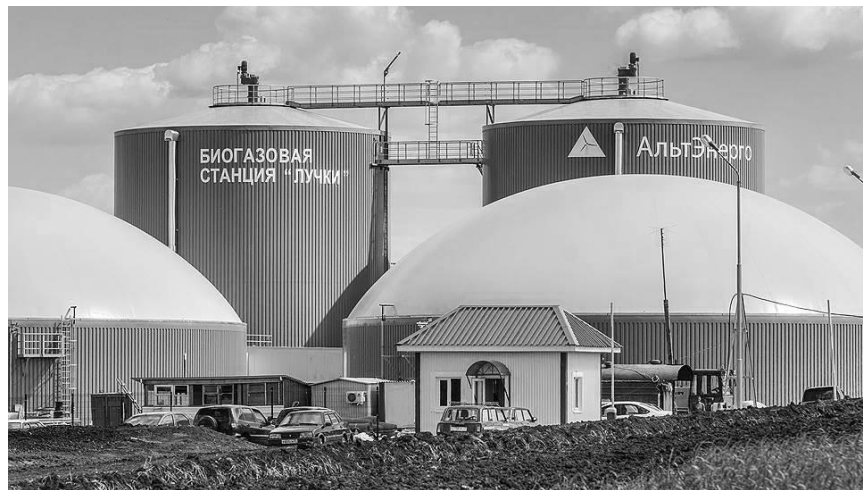
Рисунок 2.4 – Биогазовая станция «Лучки». Белгородская область
