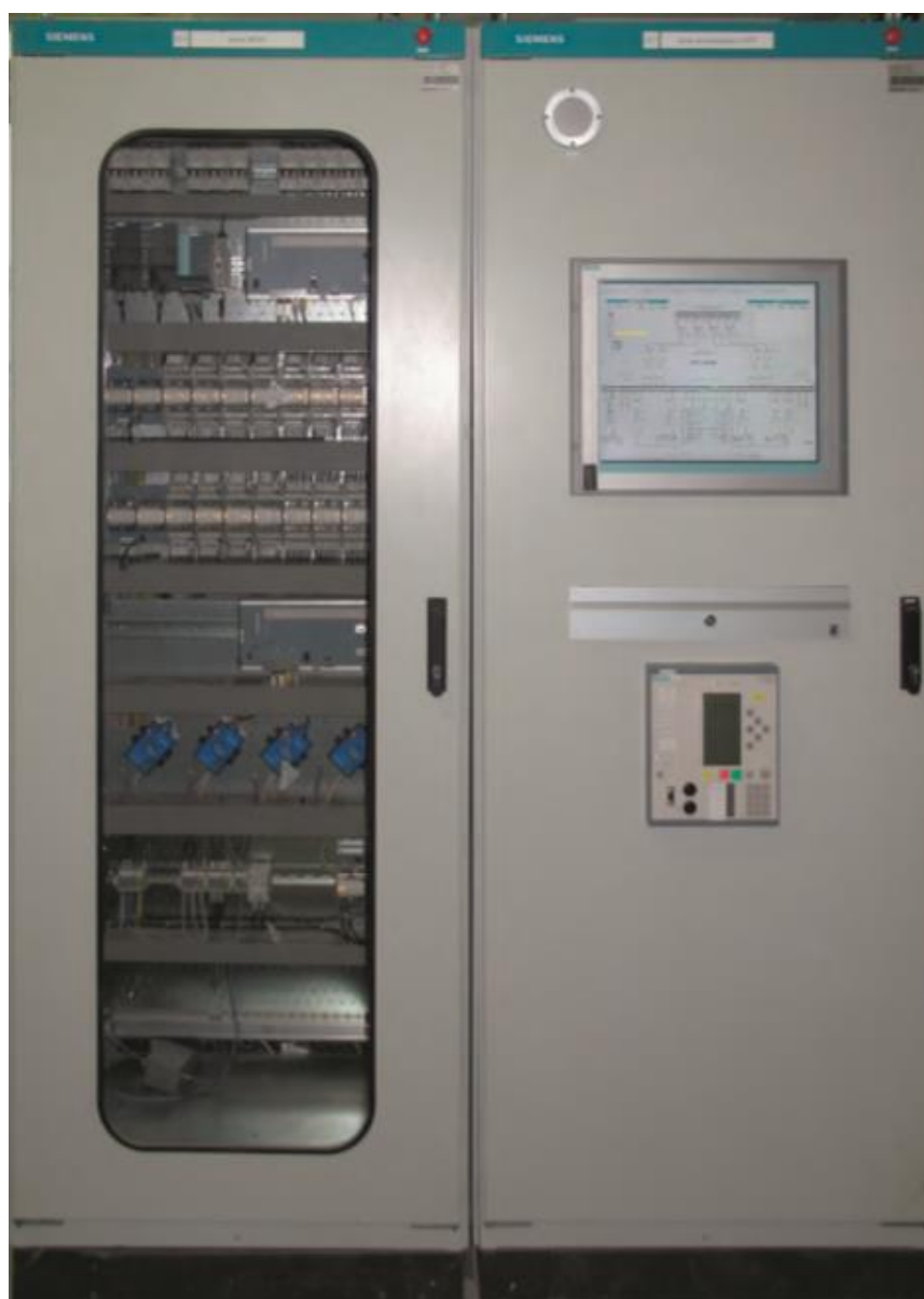
Рисунок 22 – Пример шкафа визуализации на ПС
