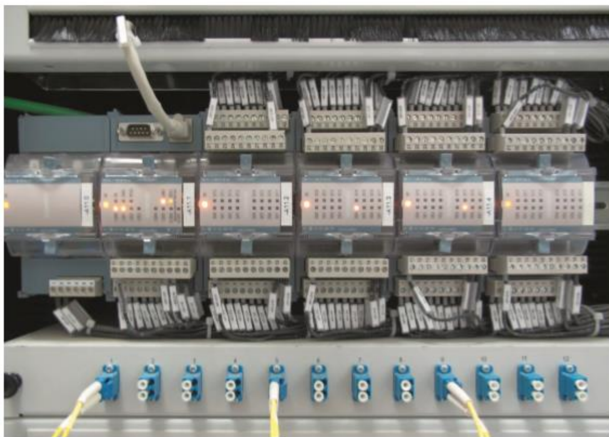
Рисунок 21 – Пример подключения контроллера ТМ 1703
