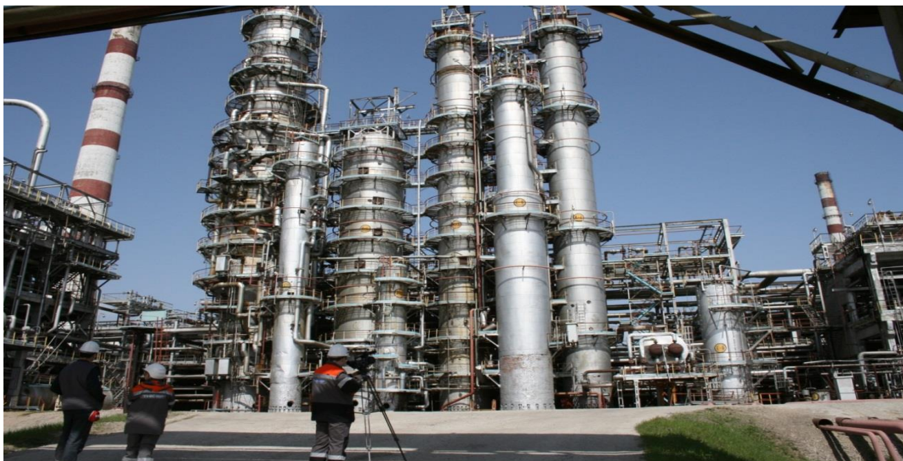
Рисунок 3.1 – Атмосферный блок установки АВТ нефтепереработки.
