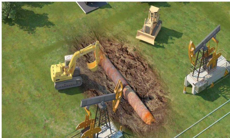
Рисунок 3.1- Извлечение вышедшей из эксплуатации трубы
