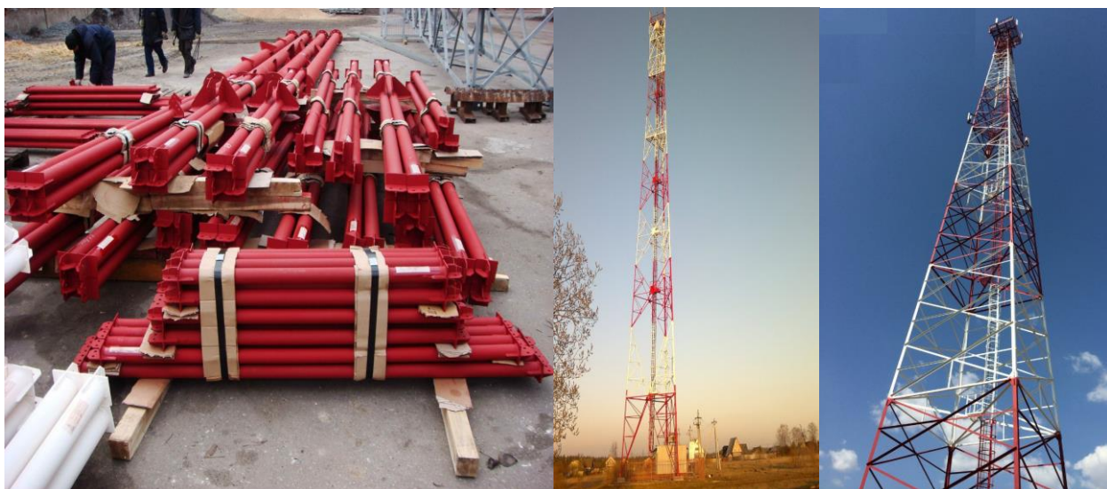
Рисунок 2.2 – Башня с оборудованием связи
