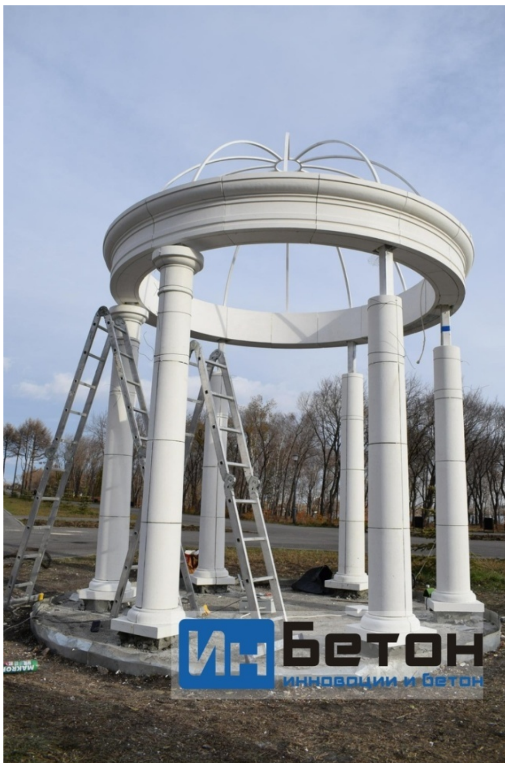
Рисунок С1 – монтаж архитектурных элементов в парке «У Вечного огня»
