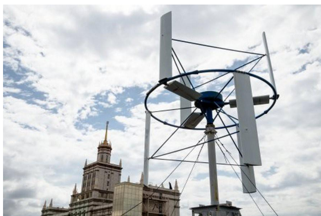
Рис. 2. Ветроэнергетическая установка мощностью 3 кВт
