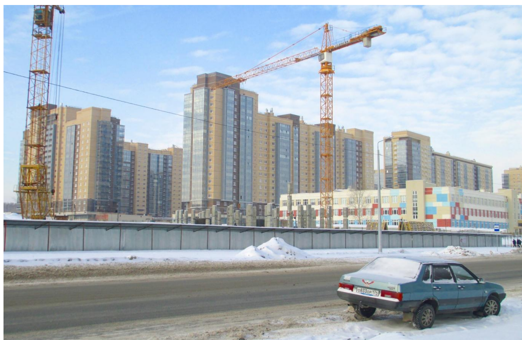
Рис. 5. Вид на новостройку жилого комплекса «Ньютон»
