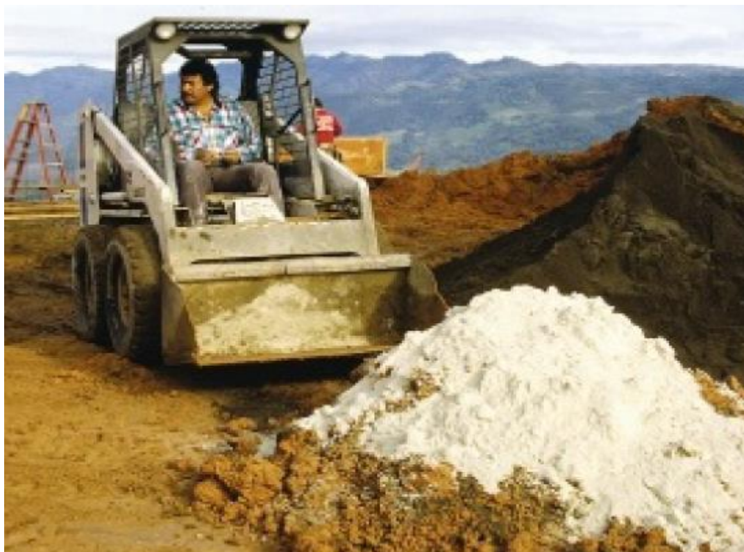
Рис .2.4.3. показано смешивание белого цемента и почвы.
