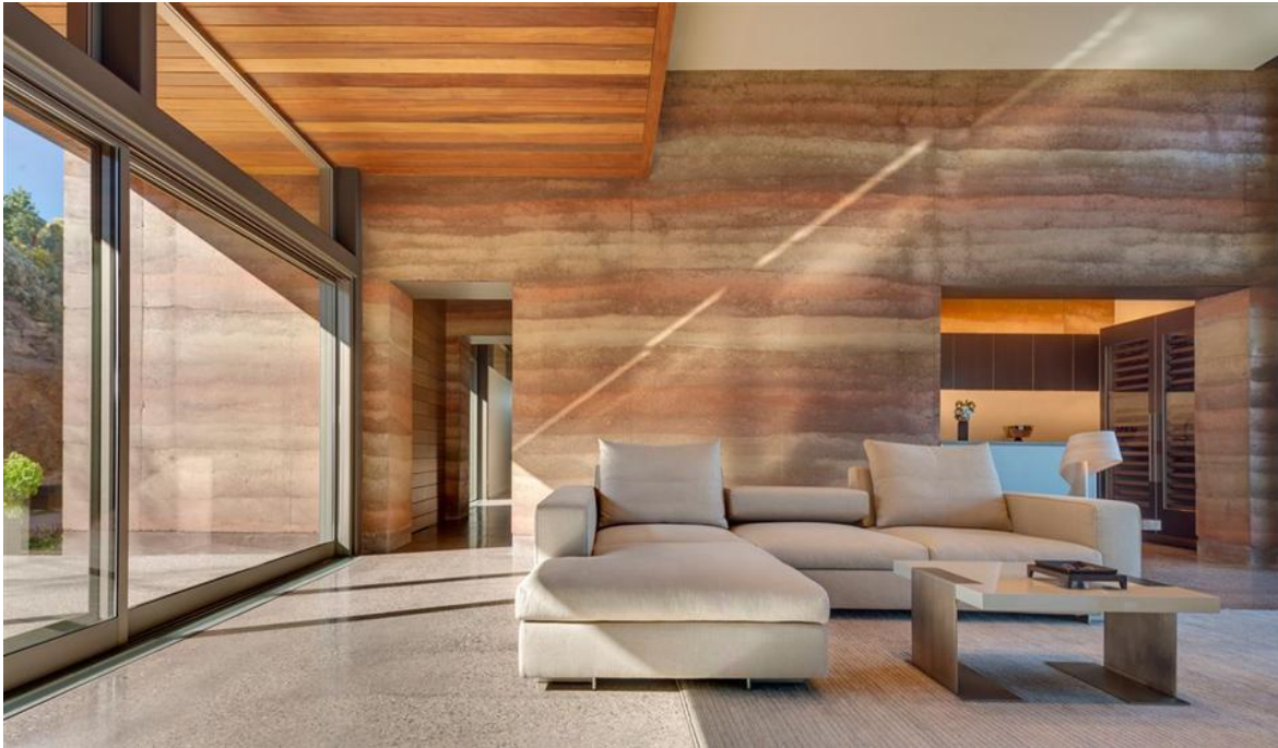
Рис.2.4.3.2: утрамбовывали землю дом с красивой натуральной текстурой
