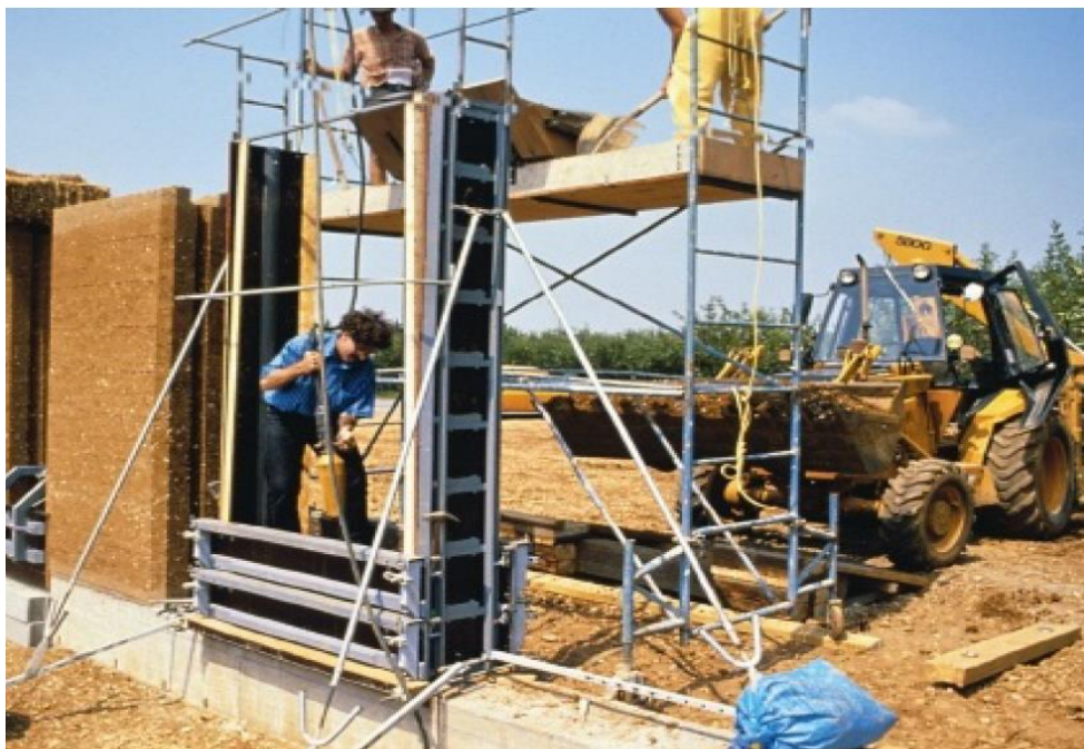
Рис.2.4.3.1а. Пневматический тампер уплотняет утрамбованную землю
