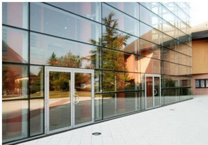
Рисунок 16 - Структурное остекление
