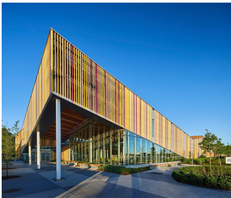
Рисунок 18 - Пример использования терракотовых трубок на фасаде
