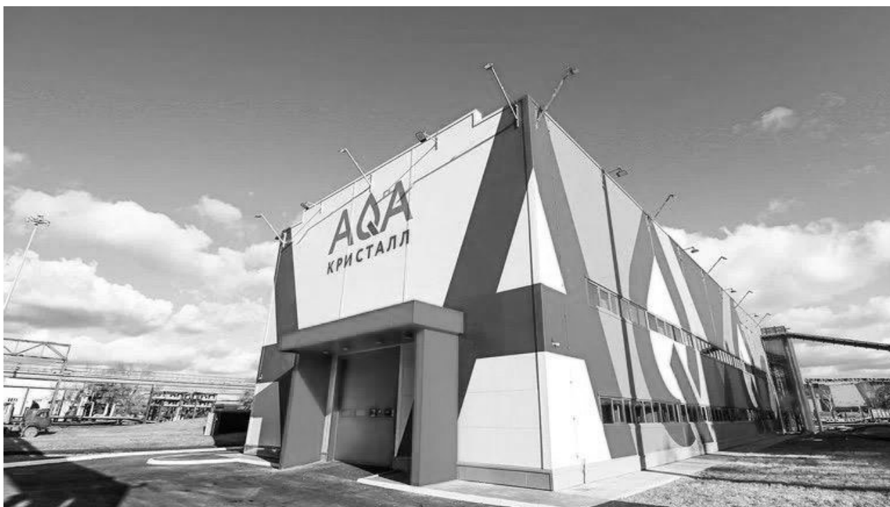
Рисунок 3.1 – Здание очистных сооружений АQA Кристалл.
