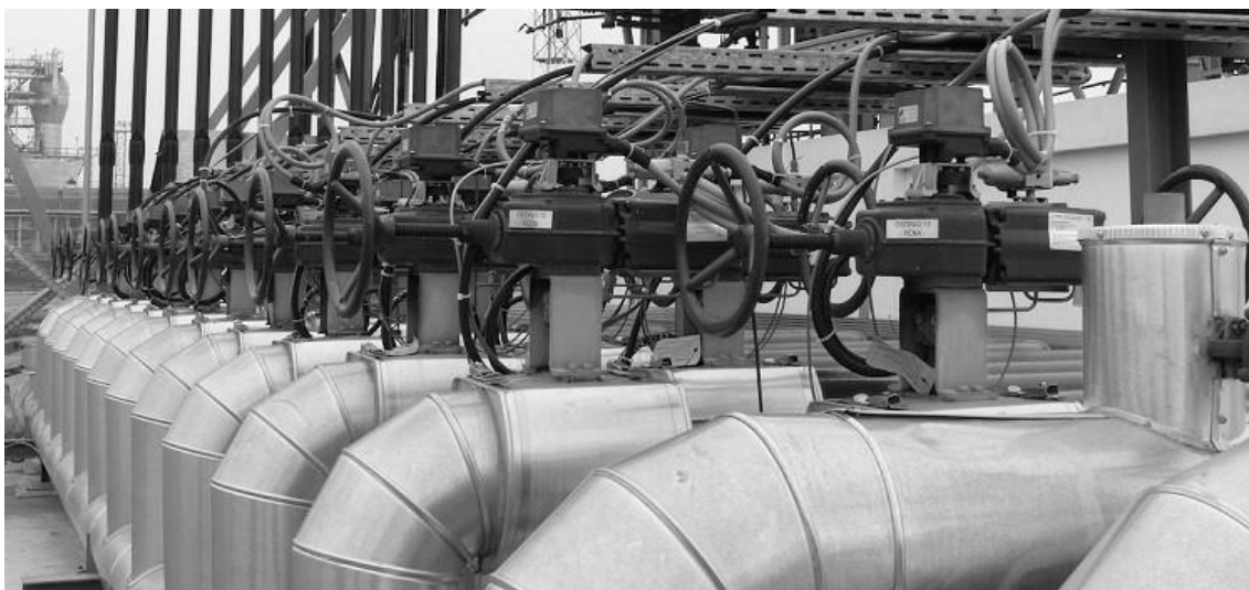
Рис. 3.5 – Присоединение задвижек с электроприводом к трубопроводам
