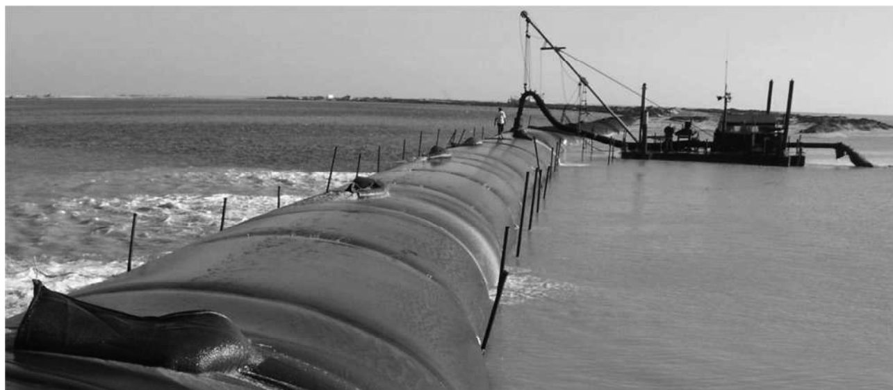
Рисунок 12 – Способ обезвоживания изъятых донных отложений с помощью технологии геотуб
