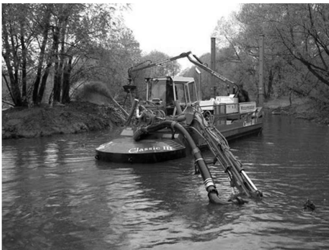
Рисунок 9 – Процесс очистки русла реки при помощи земснаряда
