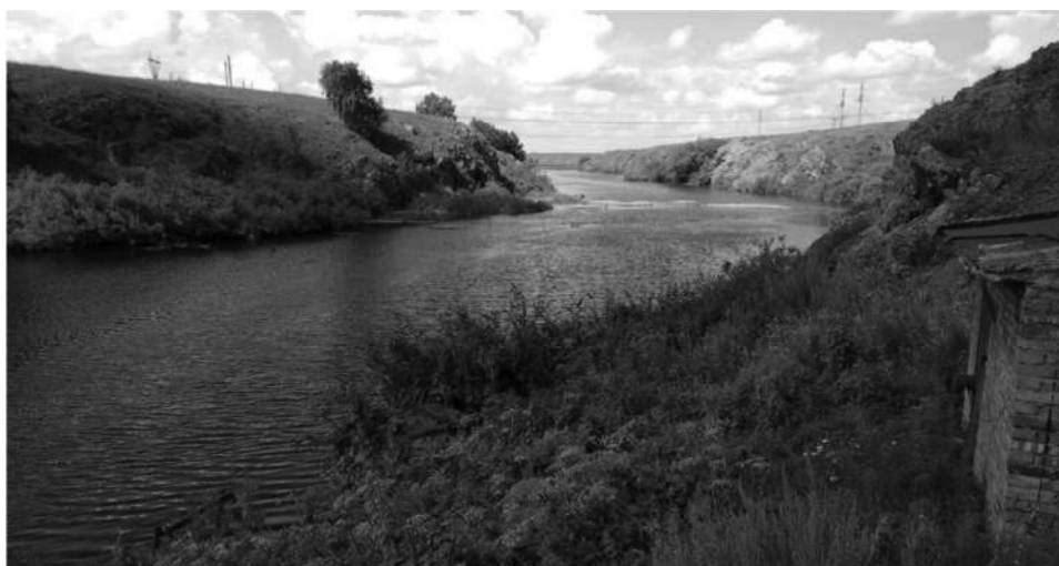
Рисунок 17 – Общий вид на реки Увелька с насосной станции I подъема
