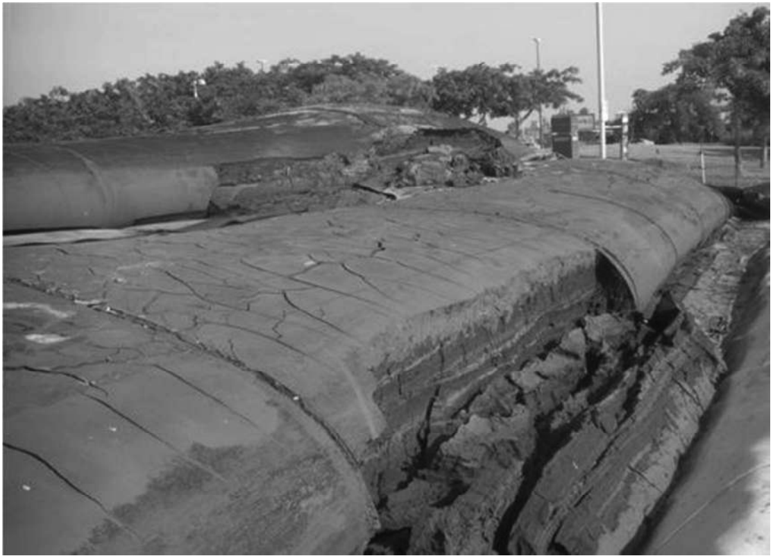
Рисунок 14 – Обезвоженные при помощи технологии геотуб донные отложения, после вскрытия емкостей
