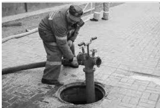
Рисунок 9 – Принцип действия пожарного гидранта
