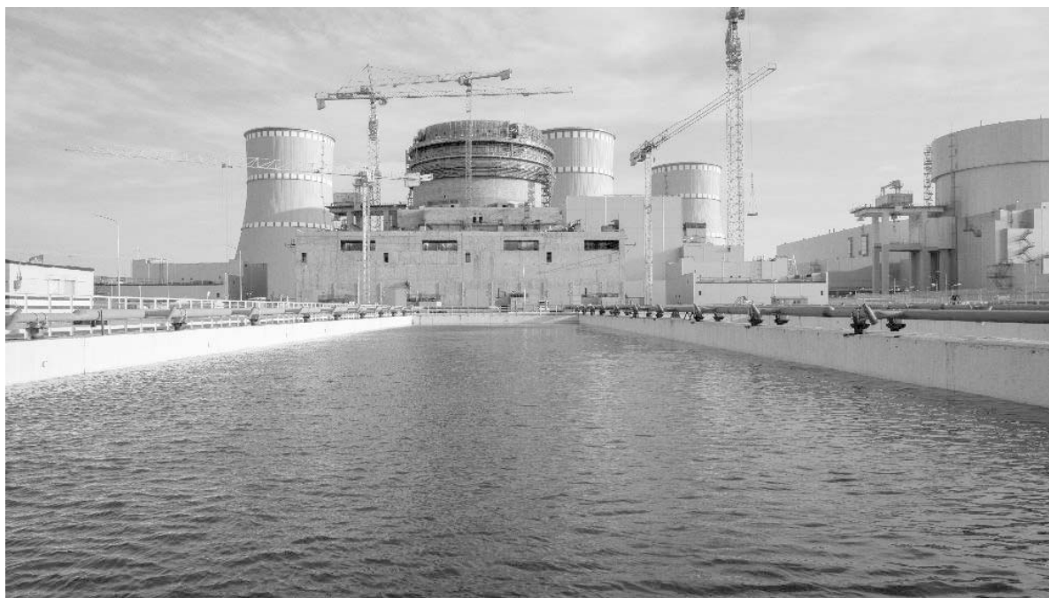
Рис.2 Строительство ректора для 2 энергоблоков Ленинградской АЭС.
