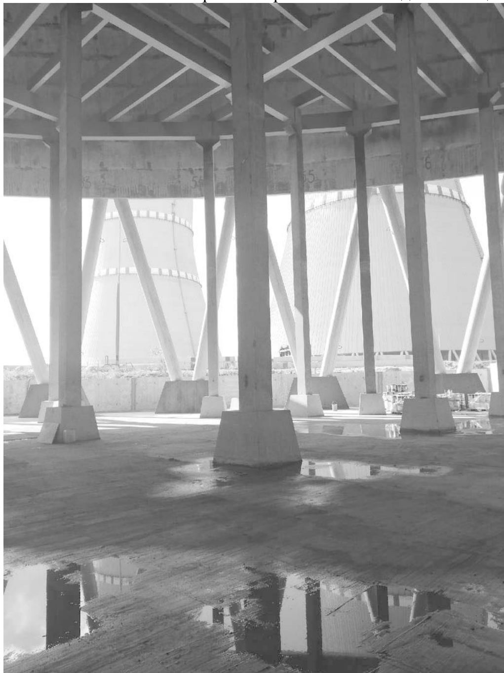
Рис. 11 Вид на смонтированные конструкции.
