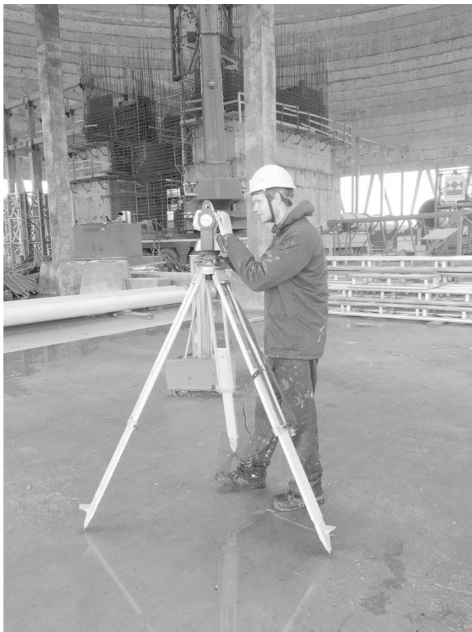
Рис. 13 Проведение разбивочных работ при строительстве градирни электронным тахеометром.
