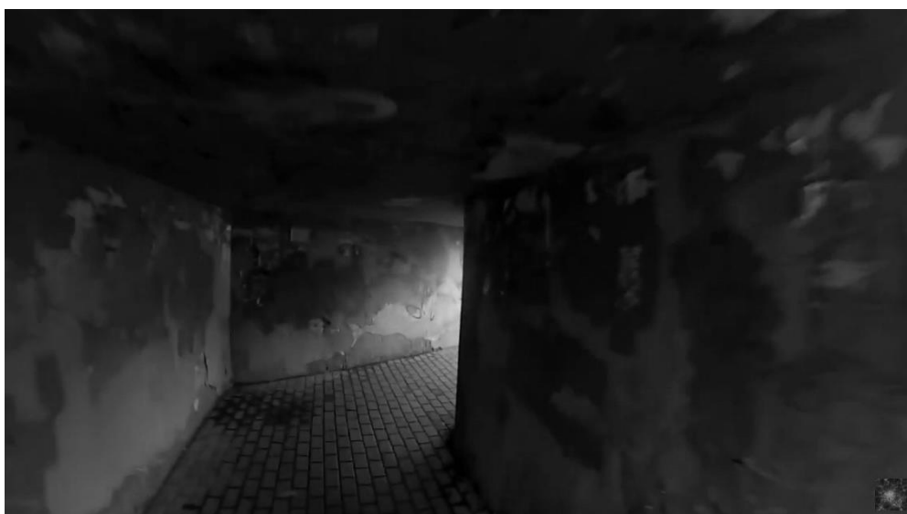
Рис.7 Прохождение тротуара сквозь нежилую часть строения
