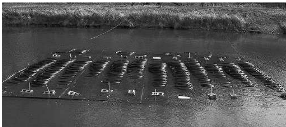
Рисунке 2.3 – Теплоприемник теплового насоса «вода-вода».
