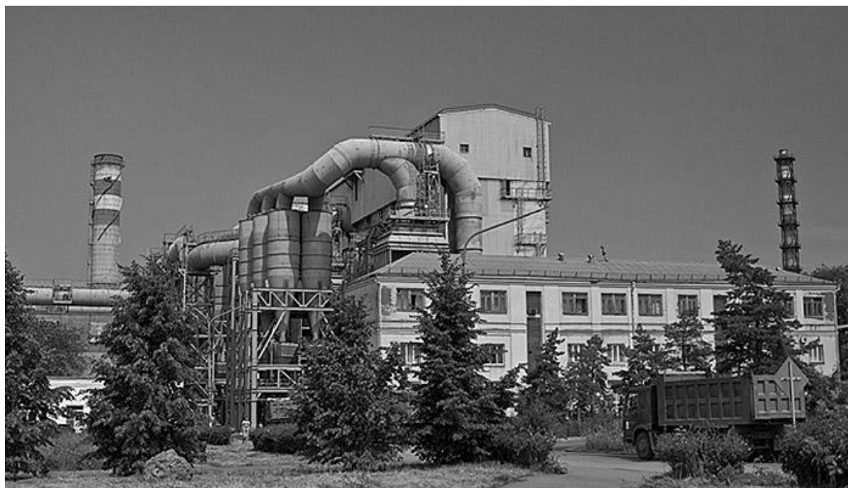
Рисунок 1.1 – Территория АО «Челябинский электрометаллургический комбинат»
