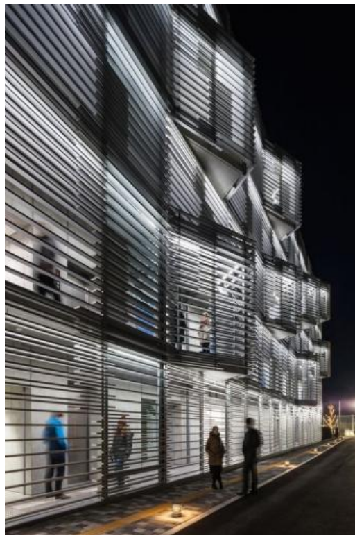
Рис. 2.14. Алюминиевая решётка на южном фасаде
