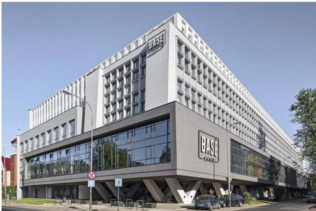
Рис. 2.36. Общежитие после реконструкции
