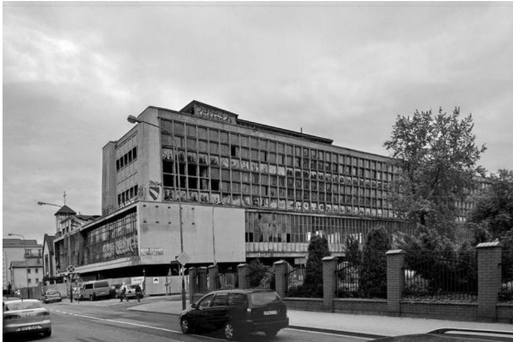
Рис. 2.35. Общежитие до реконструкции
