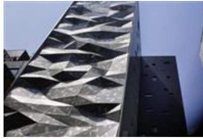
Рис. 2. Использование панелей в архитектуре
