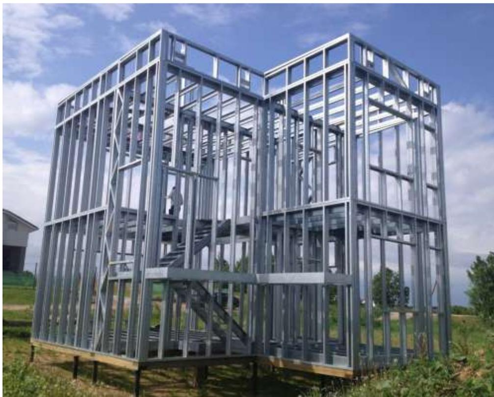
Рисунок 1.4.3 – Каркасное здание
