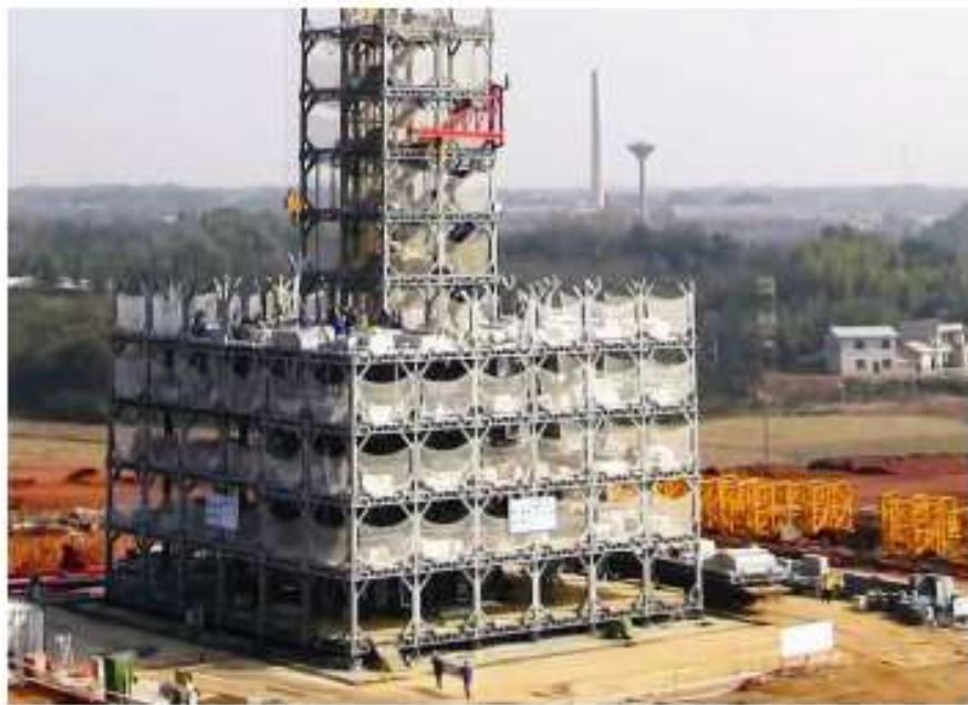
Рис. 3. Отель T30 в Китае на этапе строительства, BROAD Group
