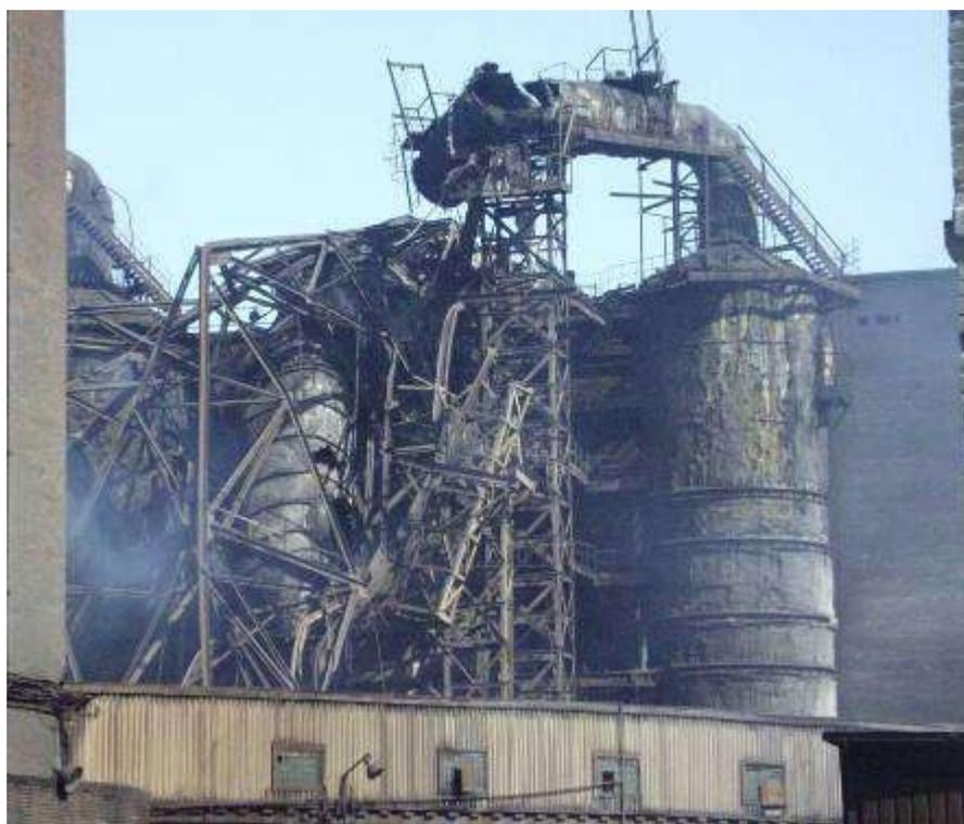
Рис. 1.2.1 Вид обрушения вытяжной башни №175
