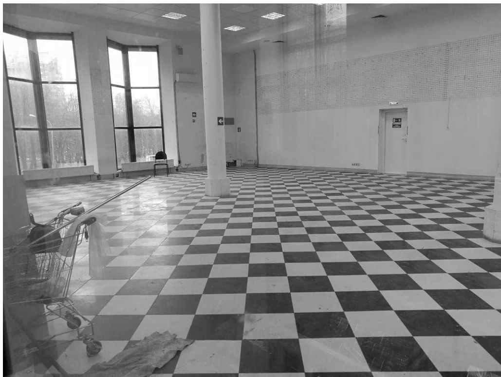
Рисунок А.6 – Здание внутри
