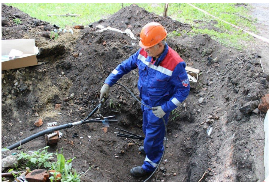
Рисунок 4 – Ремонт кабельной линии
