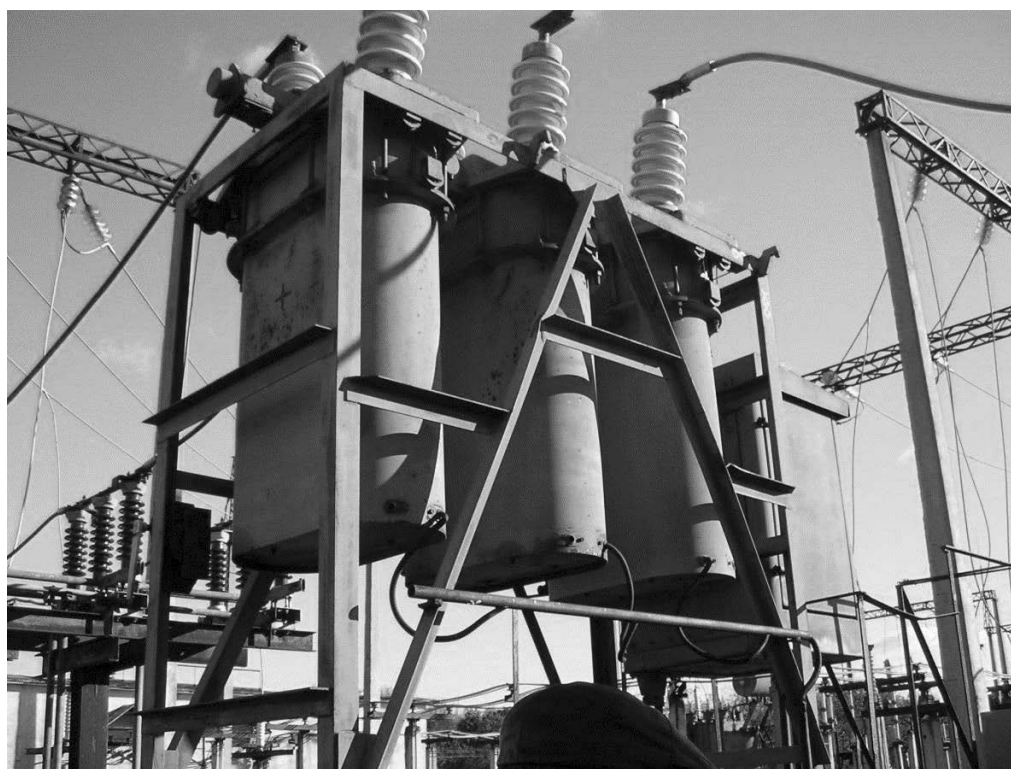
Рисунок 1.1 – Выключатель МКП-35
