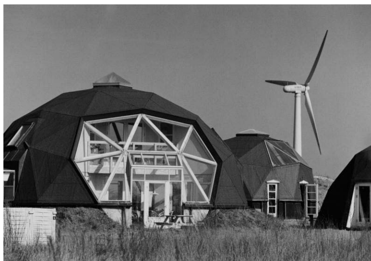
Рисунок 1.4 – Здания с нулевым потреблением энергии в экопоселении Dyssekilde
