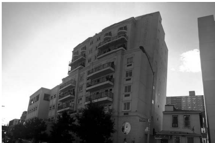
Рисунок 1.5 – Здание со стальным каркасом в Бруклине с фасадами из ЛСТК и финишной штукатуркой (строительство в начале 2000-х)
