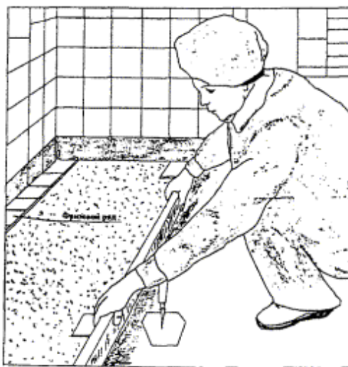
Рисунок 3.7 - Разравнивание раствора рейкой по маякам
