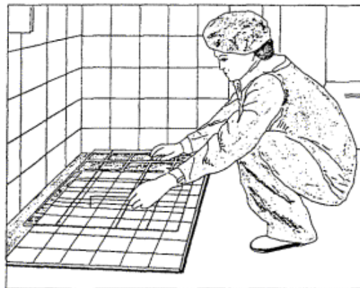
Рисунок 3.11 - Снятие шаблона
